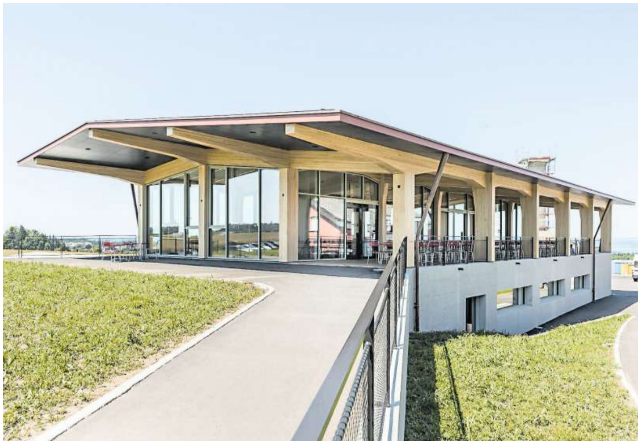
Das Gastronomiegebäude mit Grossküche und Speisesaal inszeniert die Landschaft.
