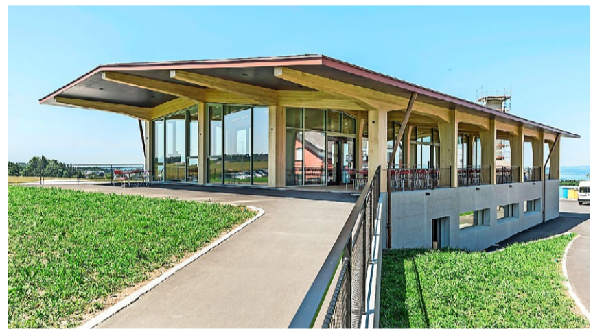
Ein Blickfang: Das auffallende Gastronomiegebäude. Lukas Peters Architektur
