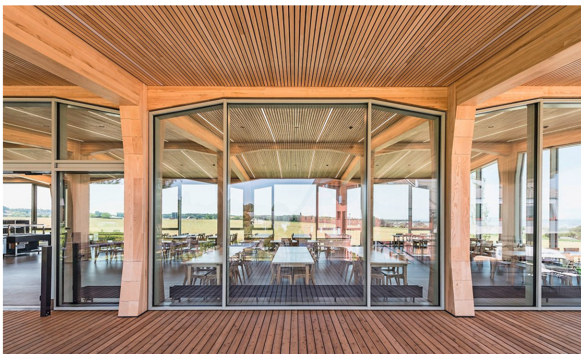
Die Tragstruktur ist aus Schweizer Esche gefertigt
