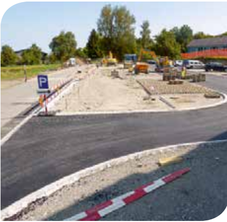
Sommer 2017: Neue Zufahrten und Parkplätze entstehen
