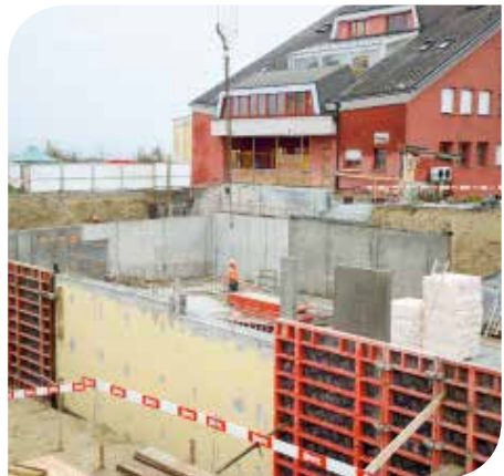
Spätherbst 2017: Die Betonarbeiten sind im Gange, das Gebäude entsteht
