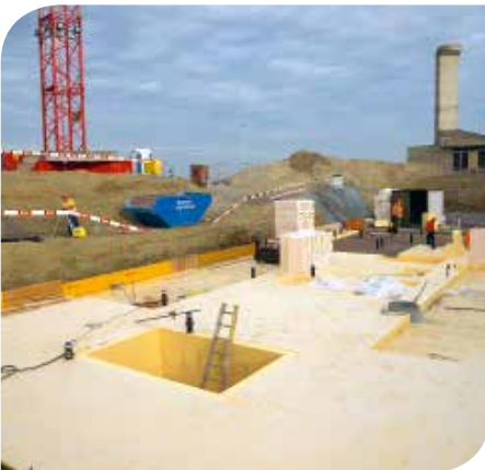
Herbst 2017: Grundlagen für die ersten Betonarbeiten sind gelegt
