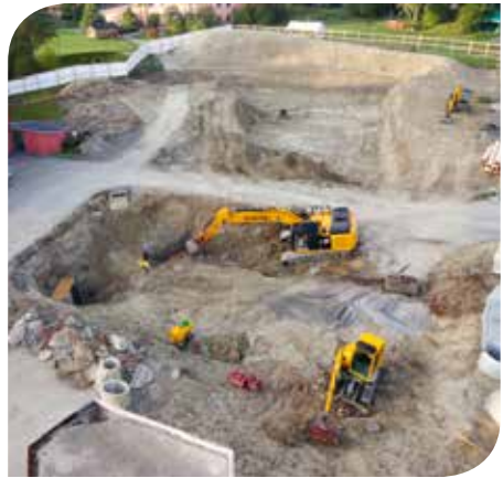
Spätsommer 2017: Aushub für das neue Gastgebäude und die Tiefgarage
